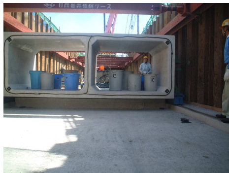
写真 5.1 落差部の移動運搬
